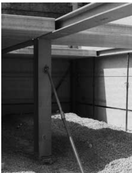
Bild 24: Stahl-Flachdecke mit Spannbetonhohlplatten
