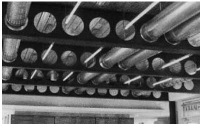
Bild 29: Installationsführung bei Lochstegträgern
