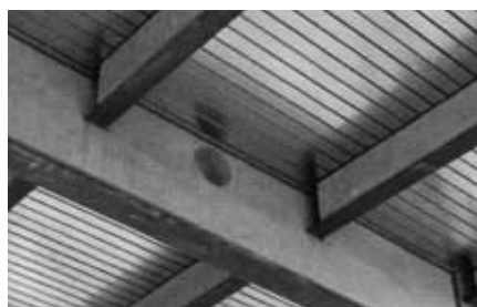
Bild 22: Verbundträgervarianten – mit und ohne Kammerbeton
