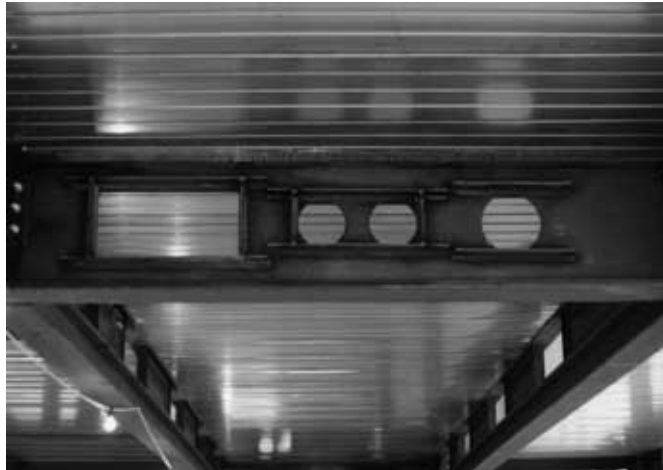
Bild 28: Stegdurchbrüche für die Installation
