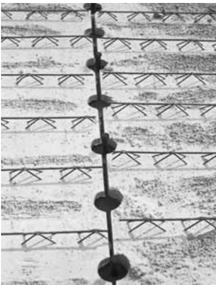
Bild 23: Filigranplatte vs. Holoribblech
