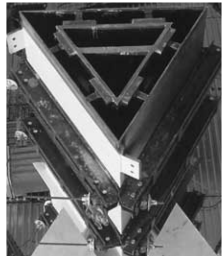
Bild 9: Stützenquerschnitt - Commerzbank Frankfurt a.M.
