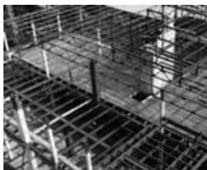
Bild 4: Deckenelemente, Haupt- und Nebenträger, Stützen
