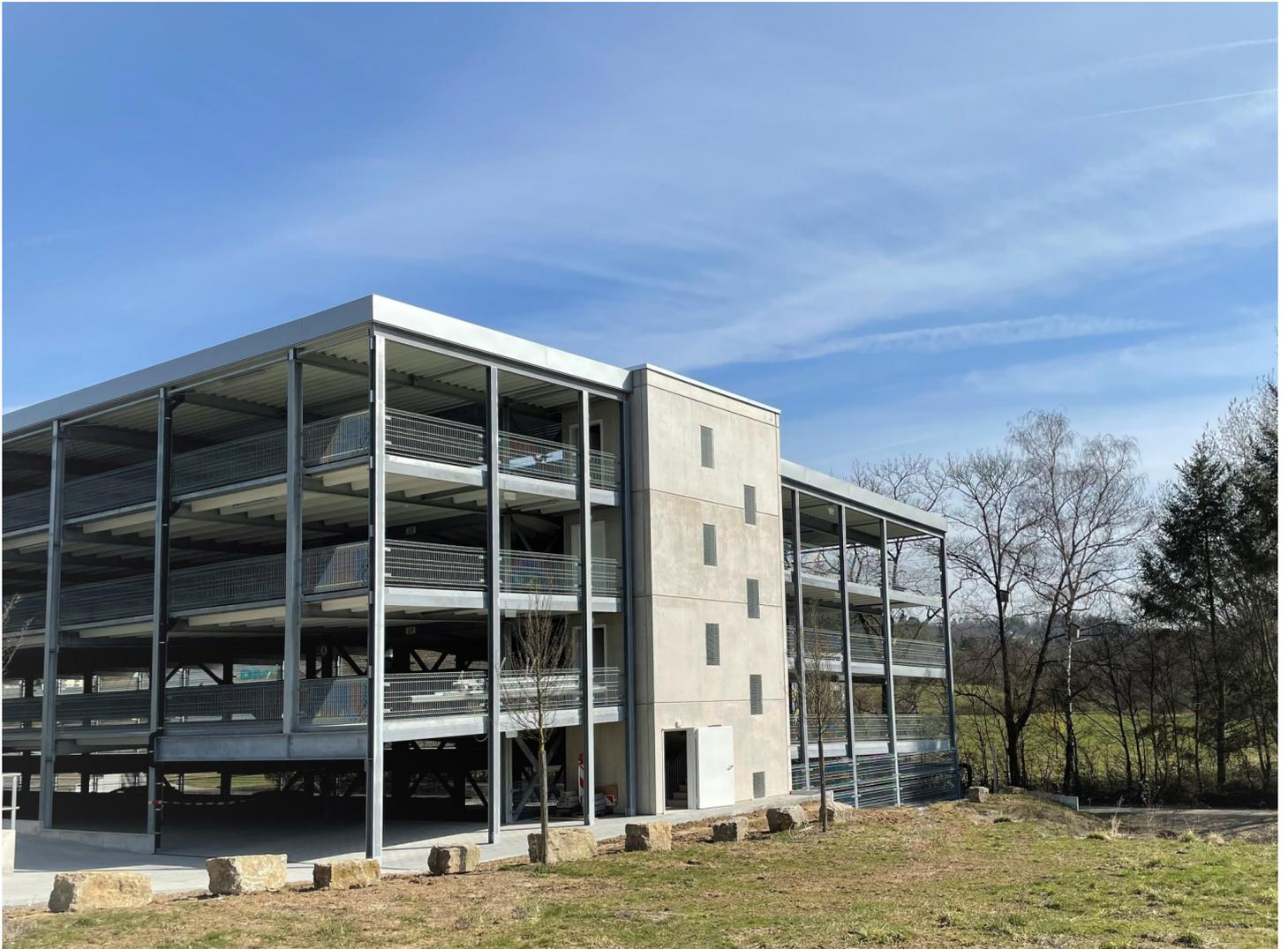
PARKHAUSABMESSUNGEN: ca. 78,00 x 32,60 m, 8 Halbgchosse (8 Stahlebenen, zwei Pflasterebenen und zwei Dachebenen)
