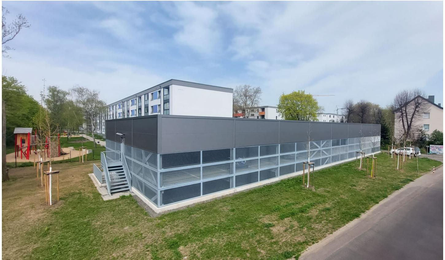
**Parkhausabmessungen:** ca. 41,60 x 16 m, eine Stahlebene, eine Pflasterebene, Überdachung
