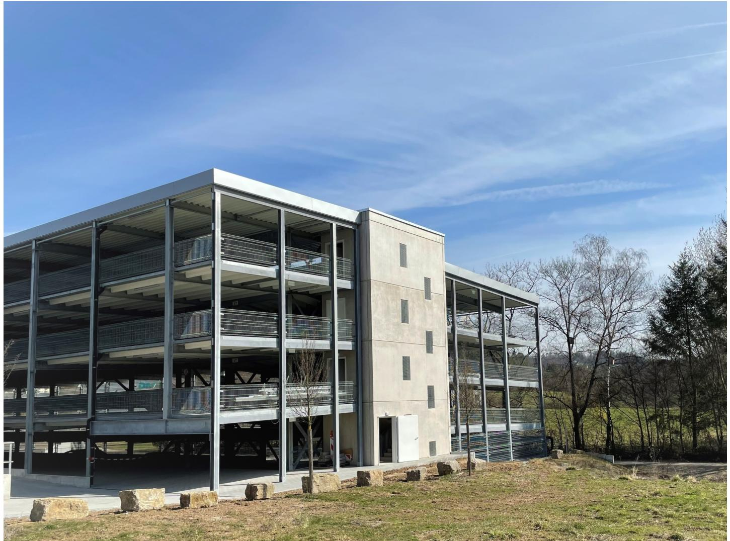
**Parkhausabmessungen:** ca. 78,00 x 32,60 m, 8 Halbgeschosse (8 Stahlebenen, zwei Pflasterebenen und zwei Dachebenen)
